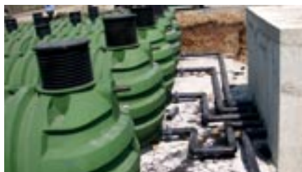
Großprojekt: 5x50.000 Liter Speichervolumen für einen US ARMY Stützpunkt (Kroatien)
