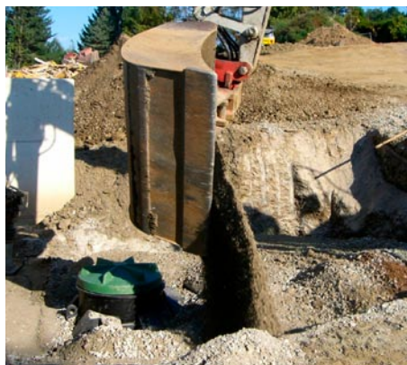
Lageweises Verfüllen und Verdichten von nichtbindigem Einbaumaterial
