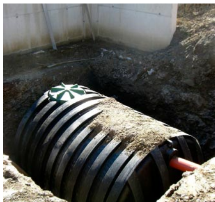
Fachgerechtes Einsetzen der PE-Sammelgrube (12.000Liter) in die Baugrube
