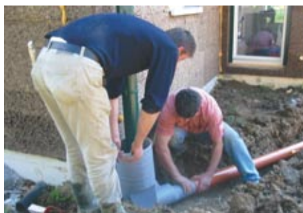
Versetzen und Einrichten des Schachtes
