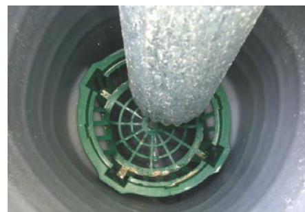
Einsetzen des Filterkorbs
