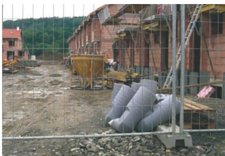
Lieferung zur Baustelle
