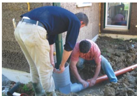
Versetzen und Einrichten des Schachtes
