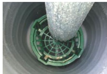
Einsetzen des Filterkorbs
