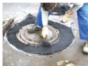
11. Kalt- oder Heißbitumen aufbringen
