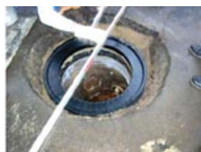
6. Eventuelles Aufsetzen und Ausrichten des 2ten Ausgleichsringes
