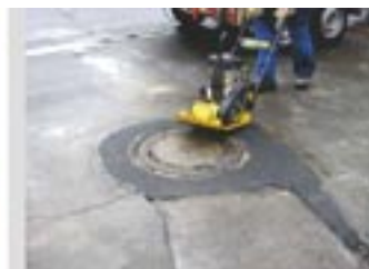
12. Verschleißschicht verdichten
