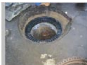
3. Auflegen des ersten Ringes auf das Mörtelbett
