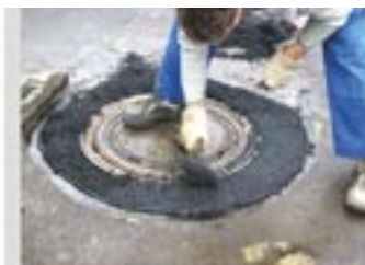
11. Kalt- oder Heißbitumen aufbringen
