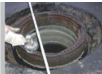
8. Aufsetzen und Ausrichten BEGU-Rahmen
