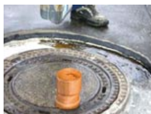
10. Haftkleber / polymermodifizierte Bitumenemulsion aufbringen
