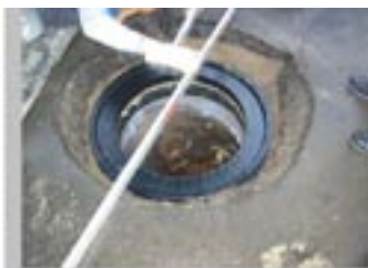
6. Aufsetzen und Ausrichten des 2. Ausgleichsringes
