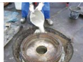
9. Verfüllen des freigelegten Fugenspalt mit Gießmörtel
