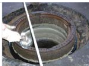
8. Aufsetzen und Ausrichten des BEGU-Rahmens
