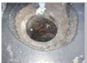
1. Freilegen und Reinigen des Konus
