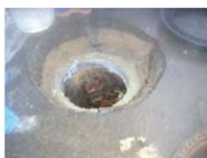
2. Aufbringen einer satten Lage Fugenmörtel
