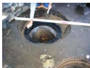
4. Ausrichten des Ausgleichsringes
