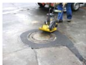
12. Verschleißschicht verdichten
