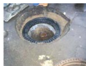
3. Aufbringen des Ausgleichsringes auf das Mörtelbett
