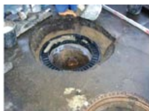
5. Aufbringen des Mörtels auf den Ausgleichsring
