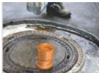
10. Haftkleber / polymemodifizierte Bitumenemulsion aufbringen
