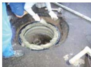
7. Vorbereitung des Mörtelbettes für den BEGU-Rahmen
