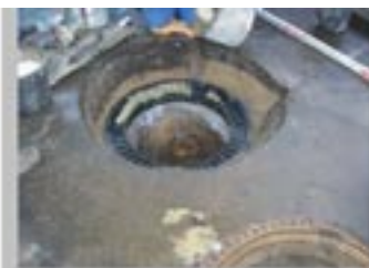
5. Aufbringen des Mörtels auf Ausgleichsring
