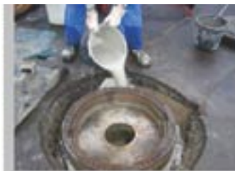
9. Verfüllen des aufgestemmen Fugenspalts mit Gießmörtel
