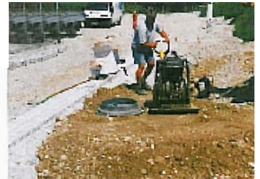
Unterfüllen des Aufsatzstückes und Verdichten
