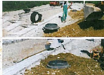
Teleskop ca. 30-50mm über die entgültige Lage positionieren
