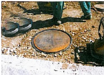
Einsatz einer Eisenplatte
