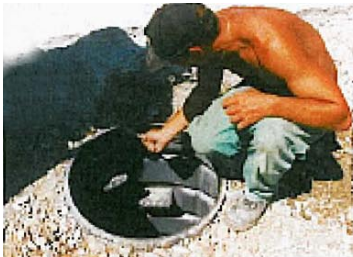
Aufbringen von Gleitmittel auf das Teleskop - Spitzende
