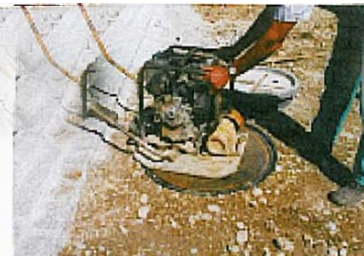
Einrütteln des Teleskops in die Trageschicht
